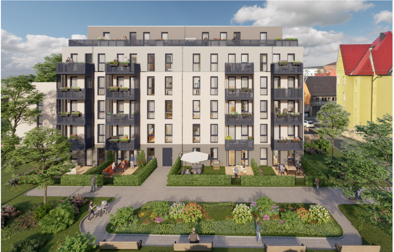
Südansicht des Gebäudeteils D
